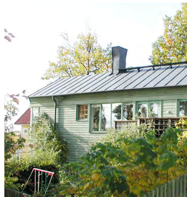
Takmaterial, falsad plåt med svart eller grafitgrå kulör.
