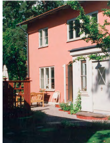
Exempel på putsad fasad.
